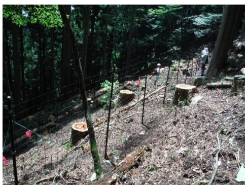
サントリープロジェクト 整備直後
