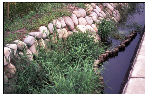
図4 上堤農業用水路の多自然護岸
